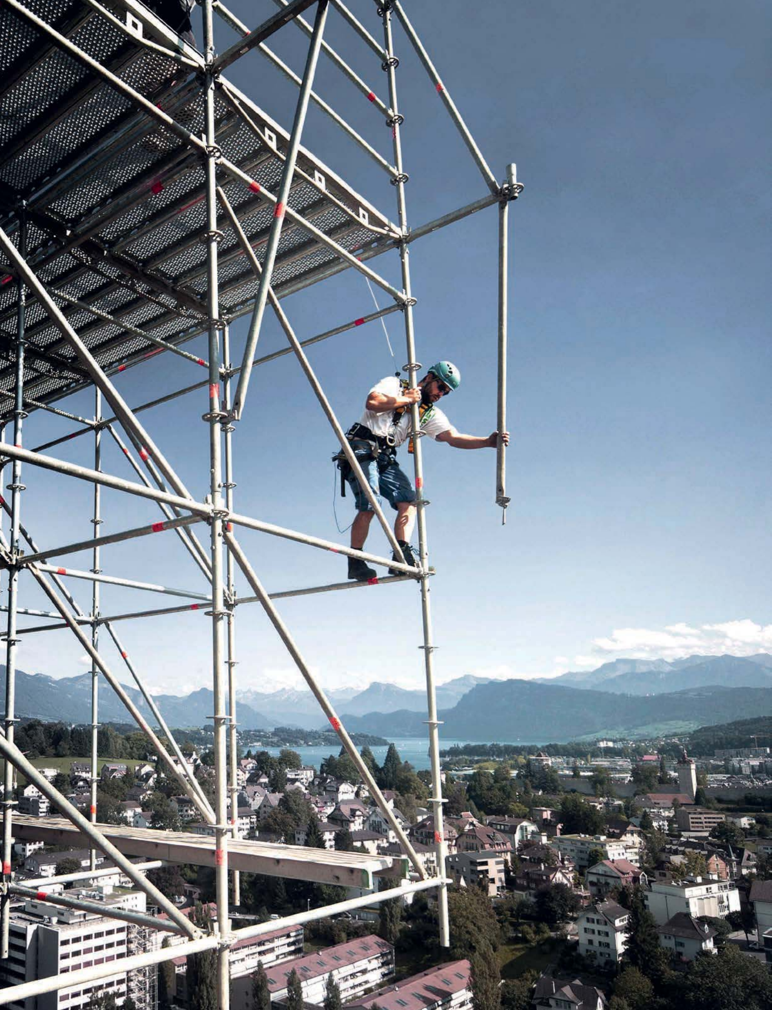
Montage eines Modulgerüsts.
