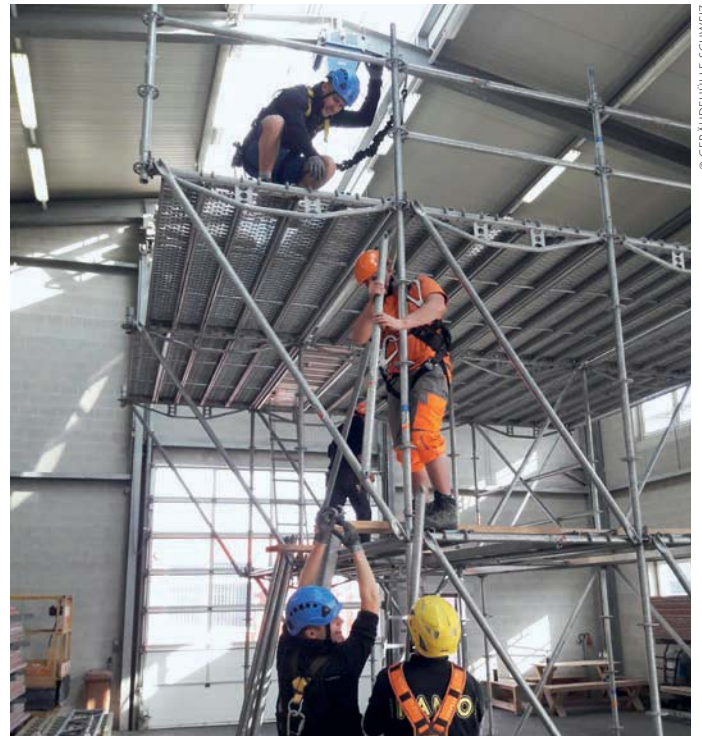
Gerüstbaulernende bei der Montage eines Modulgerüsts.
