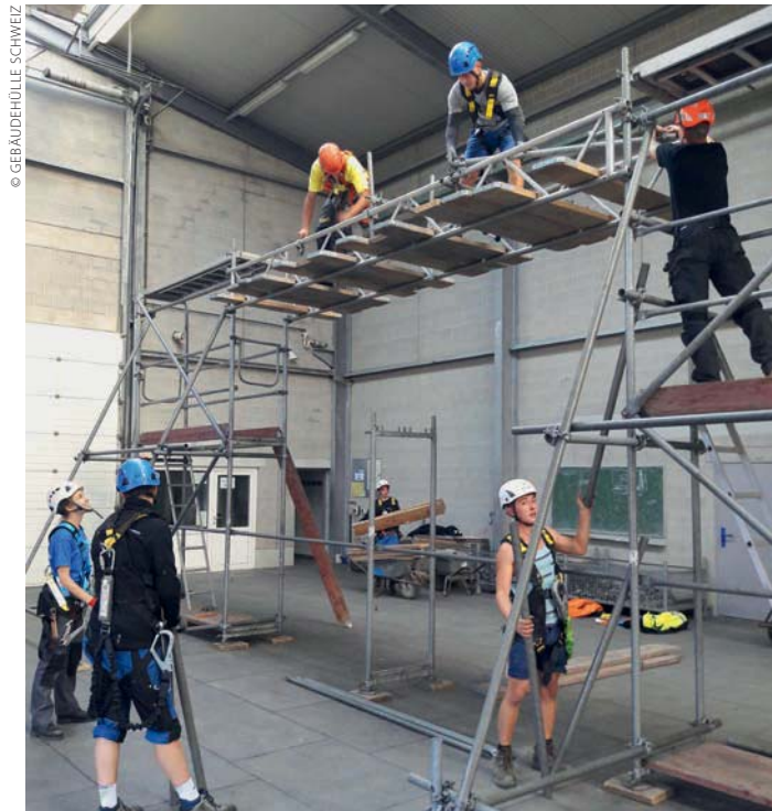
Gerüstbaulernende bei der Montage einer Überbrückung.
